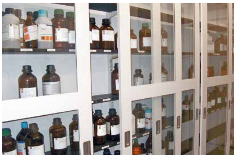
Reoler forsynet med skydelåger og ventilation
